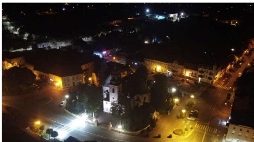
Modernizacja oświetlenia ulicznego w Witkowie. Fot. z zasobów Urzędu Gminy i Miasta w Witkowie
