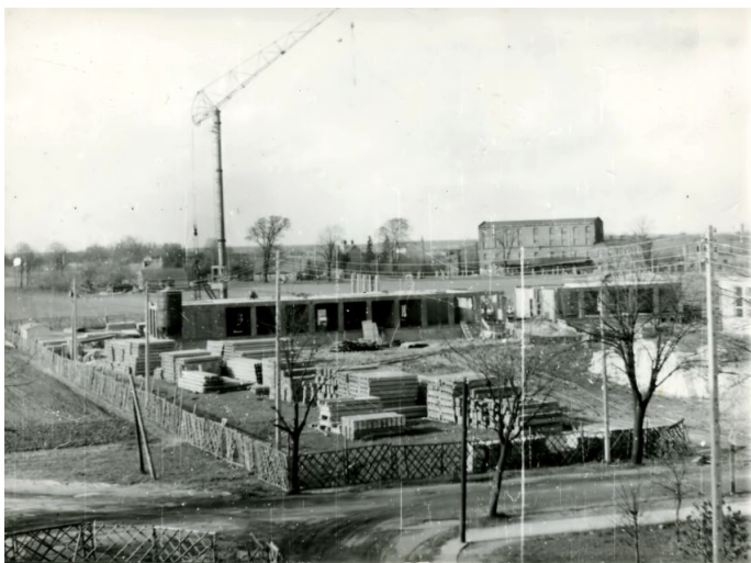
Zdjęcie 17. Witkowo – Wiosna 1971 r. w budowie Szkoła Podstawowa nr 3, fot. Z. Janke
