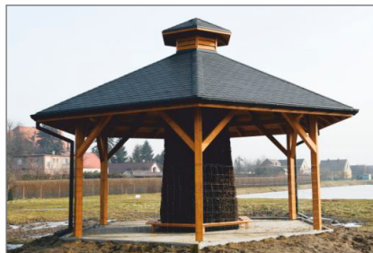
Inwestycje w realizacji – tężnia solankowa
