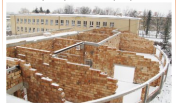
Budowa hali sportowej wraz z hollem wejściowym w Witkowie
