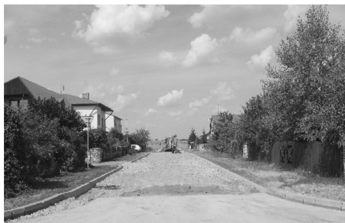
Budowa drogi na ulicy Zachodniej
