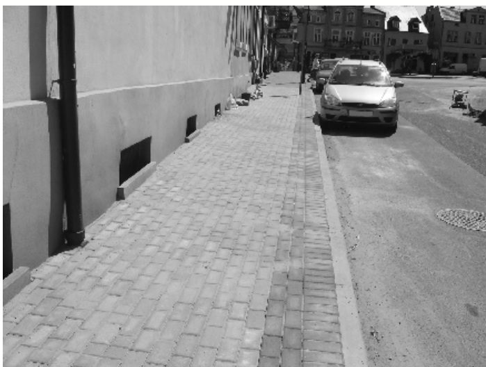
Nowa nawierzchnia chodnikowa na ulicy Nowej
