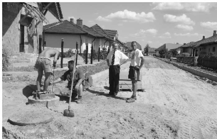
Budowa drogi na ulicy Piwnej
