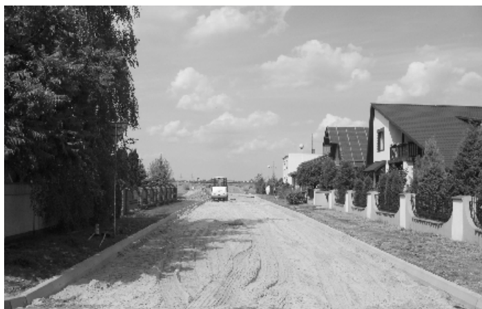
Budowa drogi na ulicy Wschodniej
