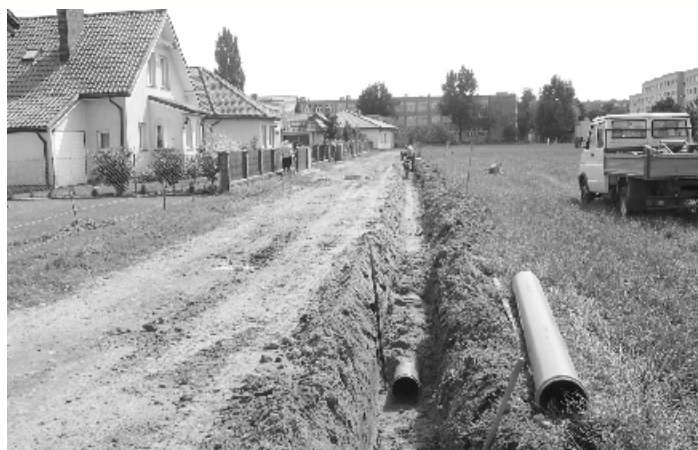
Budowa kanalizacji deszczowej ulicy Lotniczej
